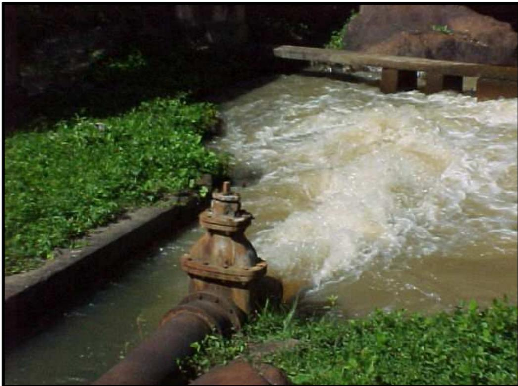
Figura VII.30 - Válvula de descarga de fundo do Açude Acarape do Meio. (Setembro/2000)
