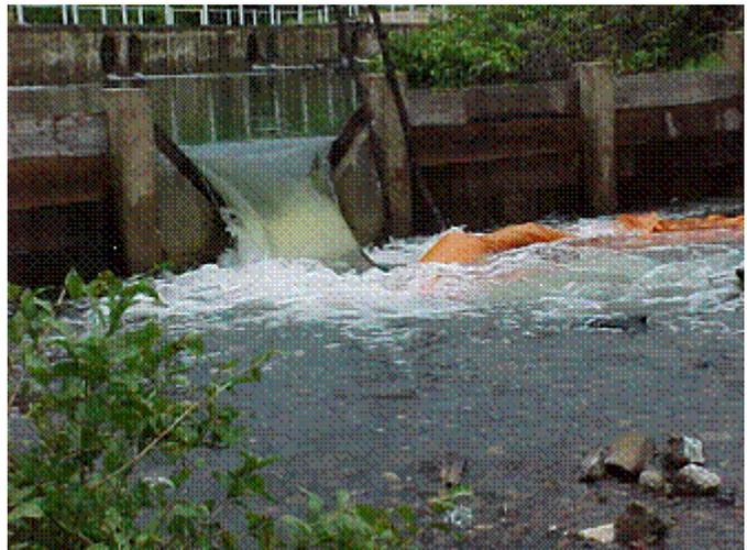
calibração dos vertedores, todos triangulares com ângulo central de 90º, foi feita após dez medidas simultâneas de carga hidráulica e vazão em 6 seções ao longo do rio. Assim, foi possível obter a equação abaixo:
