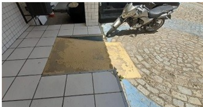
Foto 1 – Rampa de Acesso
