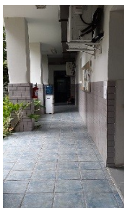
Foto 4 – Corredor de Acesso
